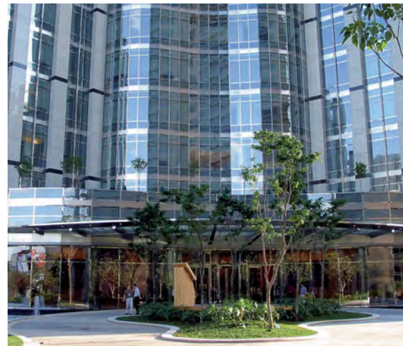
Figura B Los tres acabados de acero inoxidable pueden ser vistos alrededor de la entrada con apariencia de parque del edificio. (Fotografía cortesía de Núcleo Inox)
