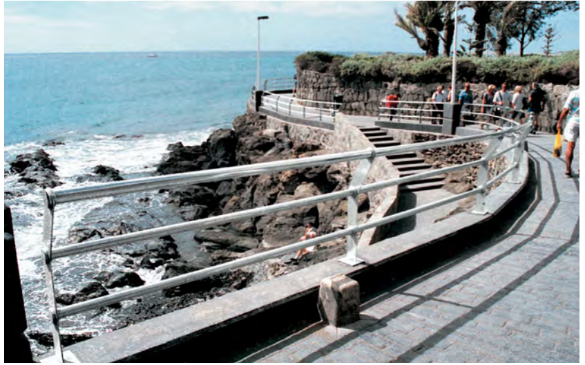
Figura A Esos barandales de acero inoxidable 2205 están expuestos al rocío de sal y a salpicaduras ocasionales. Están ubicados en la ciudad de San Augustin en las Islas Canarias. No ha habido manchado por corrosión a pesar de la exposición al rocío de sal. (Fotografía Cortesía de Outokumpu)
