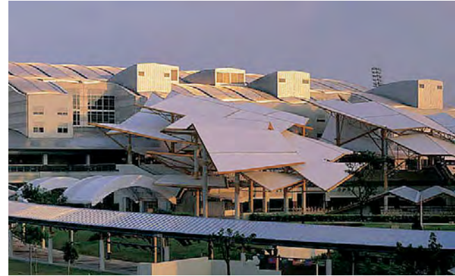
Figura A El techo de acero inoxidable tipo 316 del pasillo cubierto y la tribuna del Turf Club de Singapur parece cambiar de color durante el día. Éste refleja amaneceres, atardeceres, cielos azules y nubes. (Fotografía cortesía de Ewing Cole, Fotógrafo: Erhard Pfeiffer)
