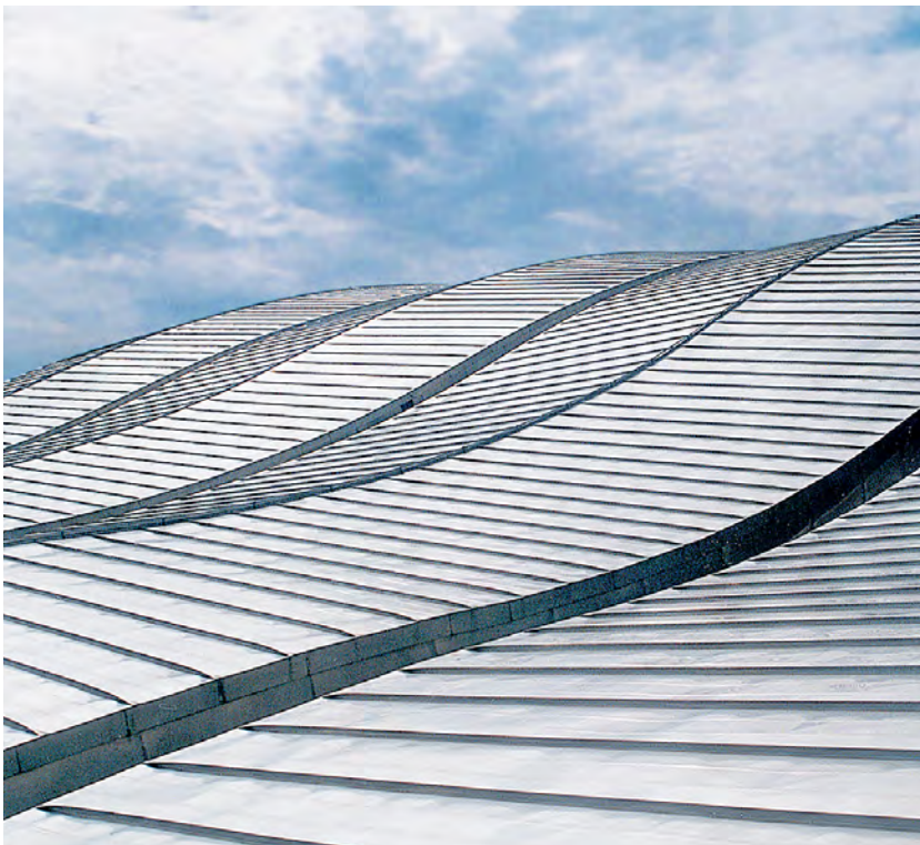
Figura B Esta fotografía muestra el diseño único del techo y el rendimiento libre de corrosión del acero inoxidable tipo 316. (Fotografía cortesía de Ewing Cole, Fotógrafo: Erhard Pfeiffer)
