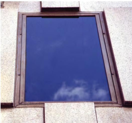
**Figura C** Este marco de ventana fabricado con acero inoxidable 304 no ha sido limpiado en cinco años. El tipo 304 que está expuesto a sal de deshielo debe limpiarse regularmente para remover los depósitos corrosivos. Aún y cuando se tomen estas precauciones, algo de manchado puede producirse entre limpieza y limpieza. (Crédito de la fotografía: Nickel Institute)
