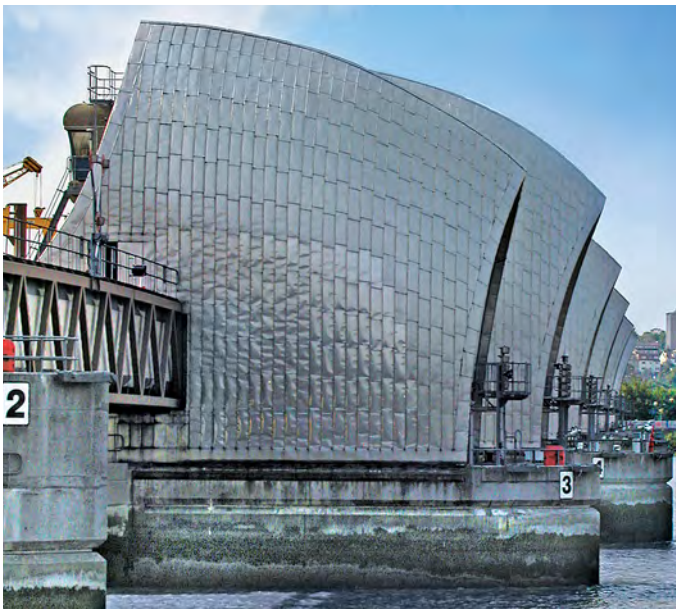
Figure B El acero inoxidable tipo 316 permanece reluciente en 2005 después de 23 años de servicio.
