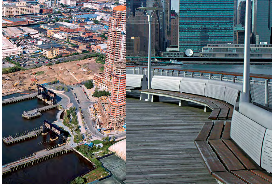
Figuras A y B Los muelles del Gantry Plaza State Park sobresalen en East River y hacen uso extensivo de barandales y asientos de acero inoxidable tipo 316. El edificio de las Naciones Unidas es visible al otro lado del río. (Figura A: Fotografía cortesía de Abel Bainnson Butz, LLP)
