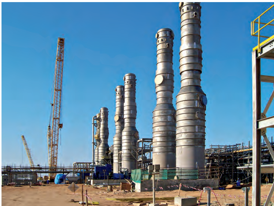
Equipamentos de recuperação de petróleo aprimorados em aço inoxidável 2507. © Aquatech
