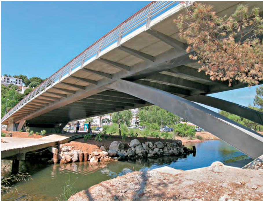
Ponte em Cala Galdana, em Menorca fabricada com aço inoxidável duplex 2205. © PEDELTA
