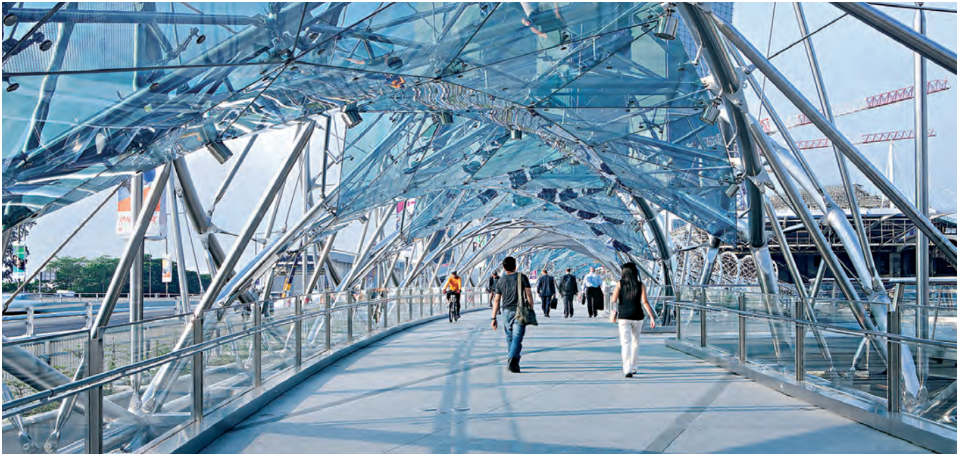
“The Helix” Passarela de pedestres, Singapura, construída com aço inoxidável duplex 2205. © Financial Dynamics/C. F. Jones
