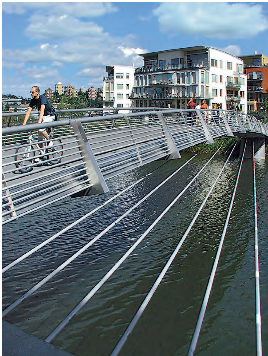
Ponte em aço inoxidável duplex em Estocolmo, Suécia. © Outokumpu
