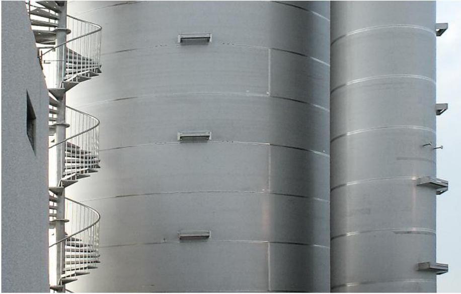
高31米 (102英尺) 的2205双相不锈钢储罐的一部分 © Outokumpu
