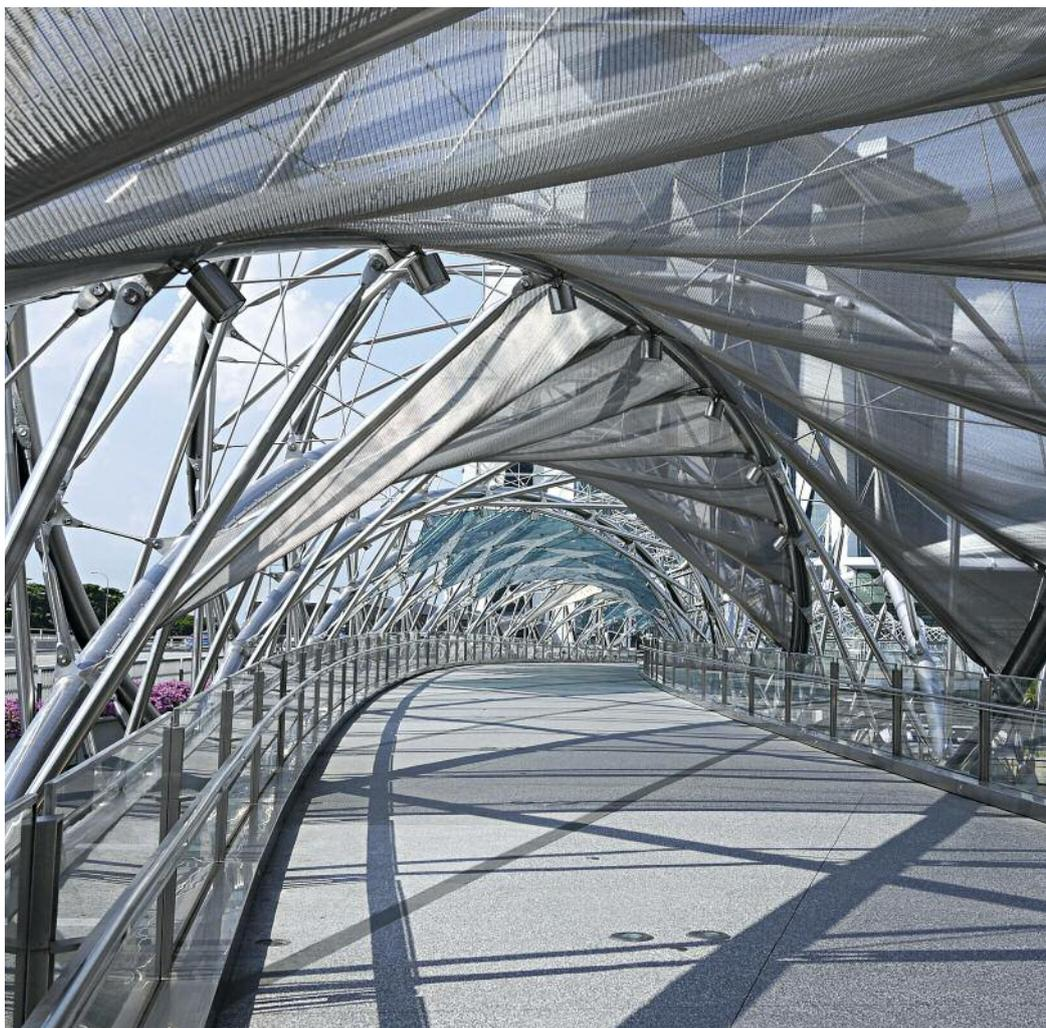
新加坡双螺旋步行桥，由2205双相不锈钢建造
