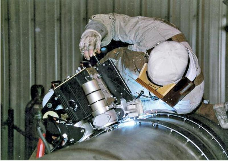
阿拉斯加北坡的大直径双相不锈钢管道的机械化焊接
