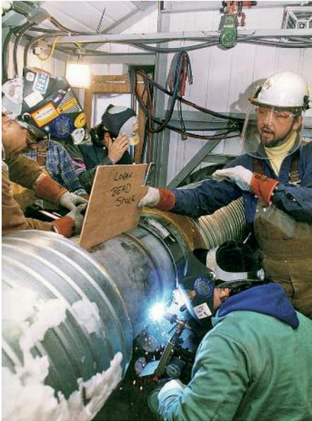
大口径双相不锈钢跨境管道的机械化焊接
