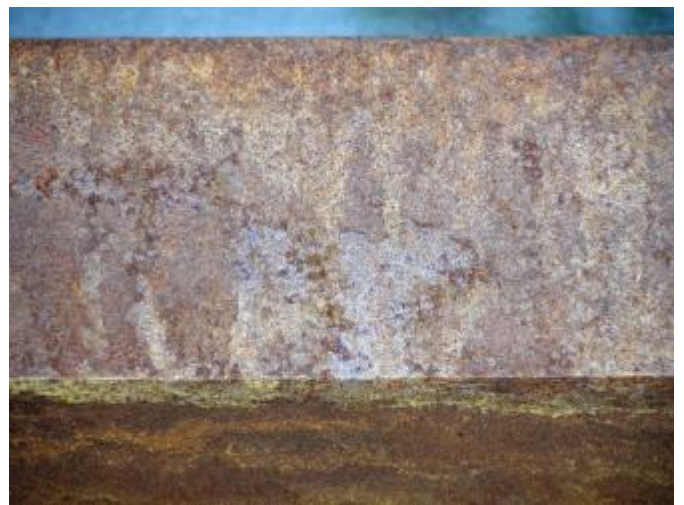
图 8: 一幢大楼外部的耐候钢材料遭受除冰盐破坏
