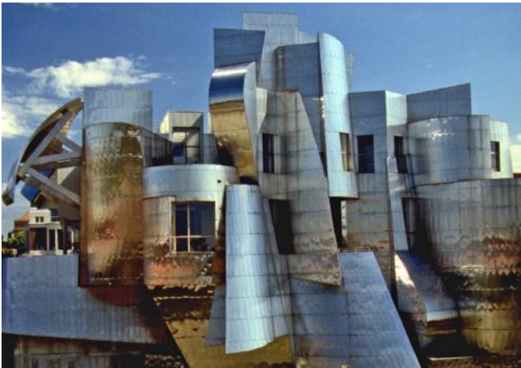
图 1: 弗雷德里克 R.威斯曼艺术博物馆外表采用精细 4 号抛光表面的 316 不锈钢,表面光滑,很容易被雨水冲刷。尽管该博物馆每年除冰盐的接触量很大,但是它依然表现出良好的性能。建筑物外表没有明显腐蚀锈迹,只有一些积尘。
