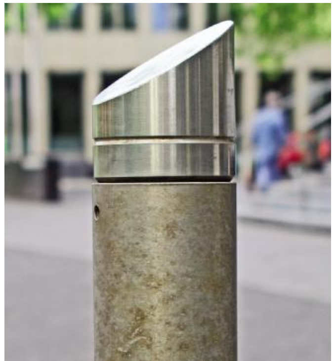
图 10:德国杜塞尔多夫一条公路旁的 316 型不锈钢隔离柱。图片由国际钼协会尼克·肯斯曼提供
