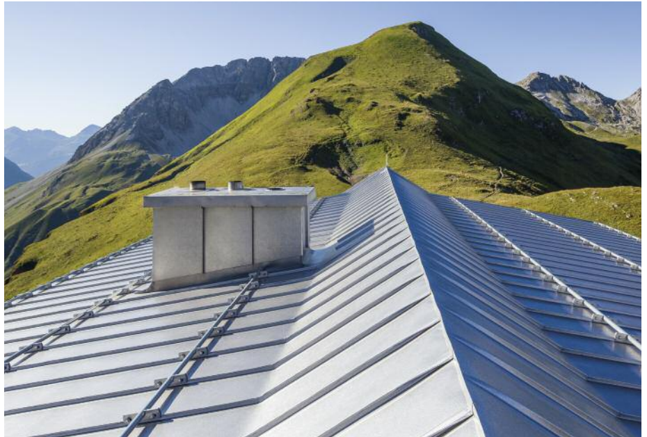
不锈钢直立锁边屋顶采用双锁技术实现永久性密封，以适应山区大风、大雪和极端温度等恶劣环境。© Roofinox
