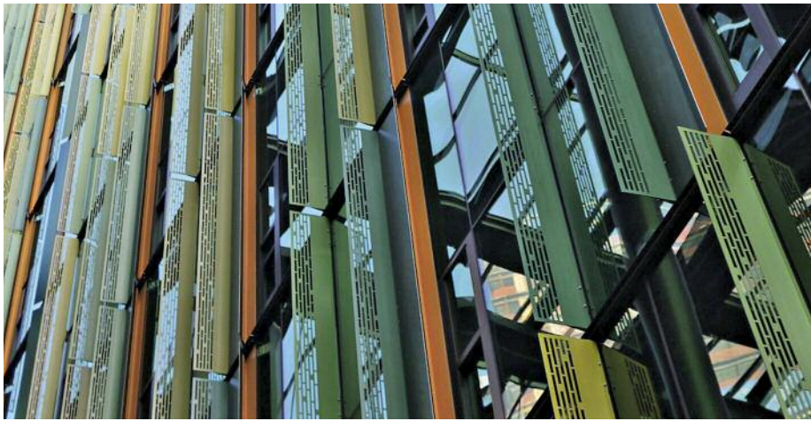
西雅图多普勒大楼上的电化学着色不锈钢“鳞片”。© IMOA
