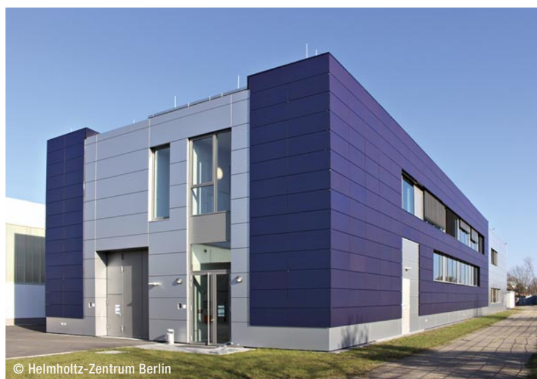
柏林研究机构的建筑外立面集成了定制蓝色的刚性 CIGS 电池板，与金属包覆层相得益彰
