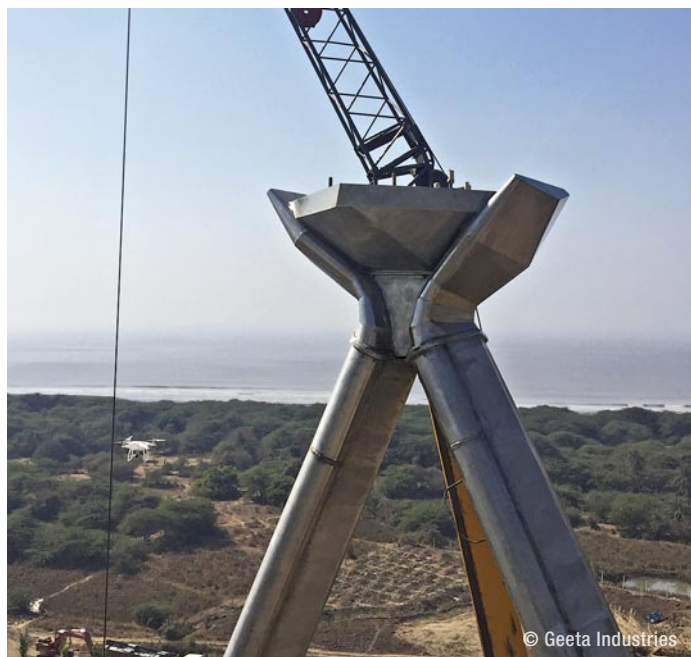
➤ 安装玻璃盐晶前的A型框架顶部
