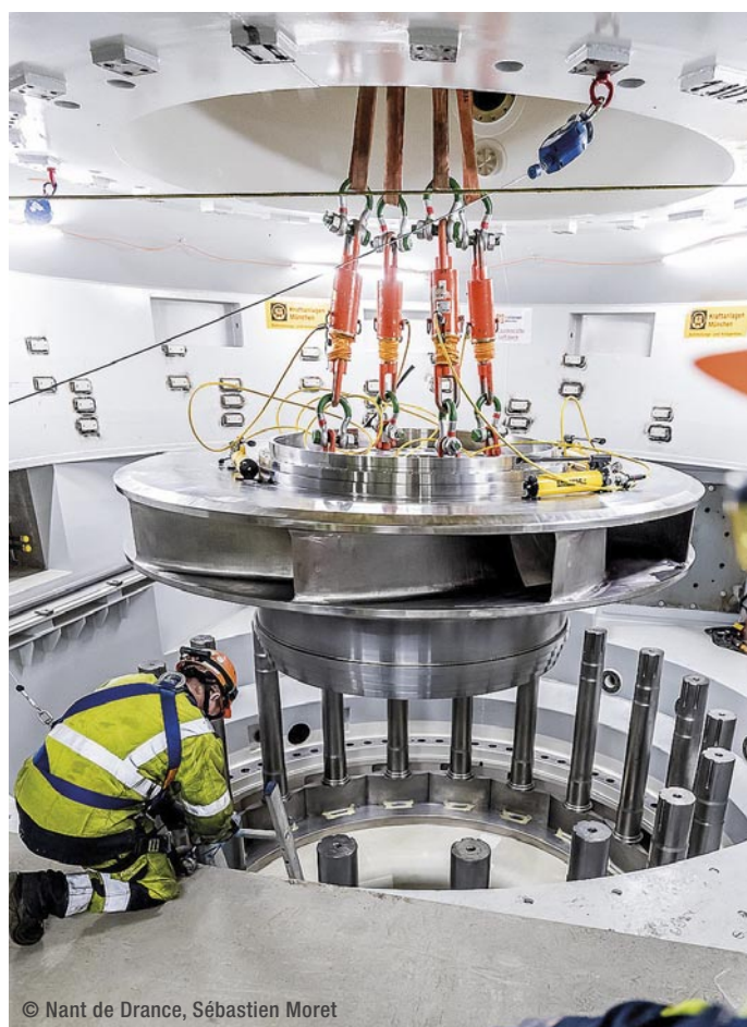
水泵水轮机的安装。水轮机叶片由马氏体不锈钢制成，钼含量为0.3–1.0%
