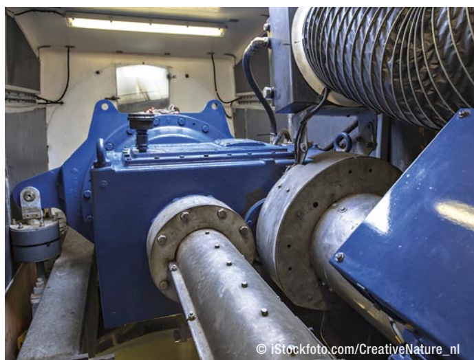
➤ 带有传动系统的风力发电机机舱内部
