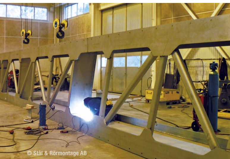
在车间手工焊接预制桥段
