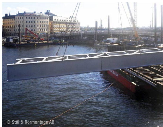
海上吊车将桥梁部分从驳船上吊起并安装到位
