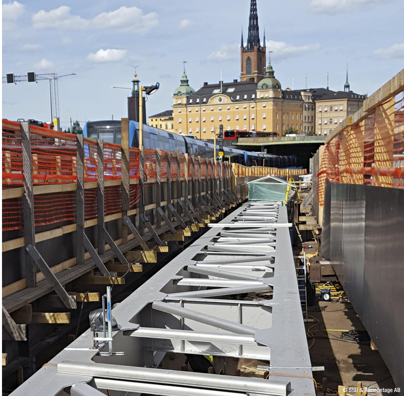
新的轨道安装在离运行中的列车仅几米远的地方
