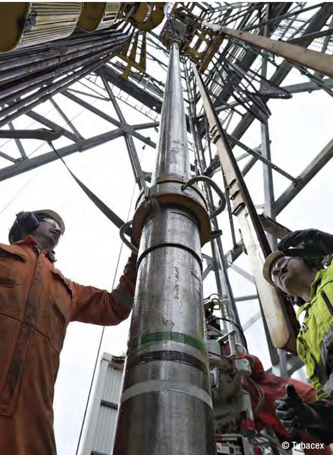
➤ 超级双相不锈钢井下管的安装
