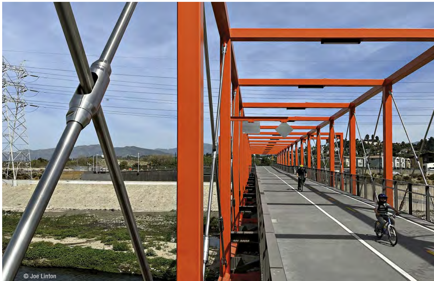
▶ 相对纤细且高反光性的拉杆，确保通行时视野通透无遮挡
