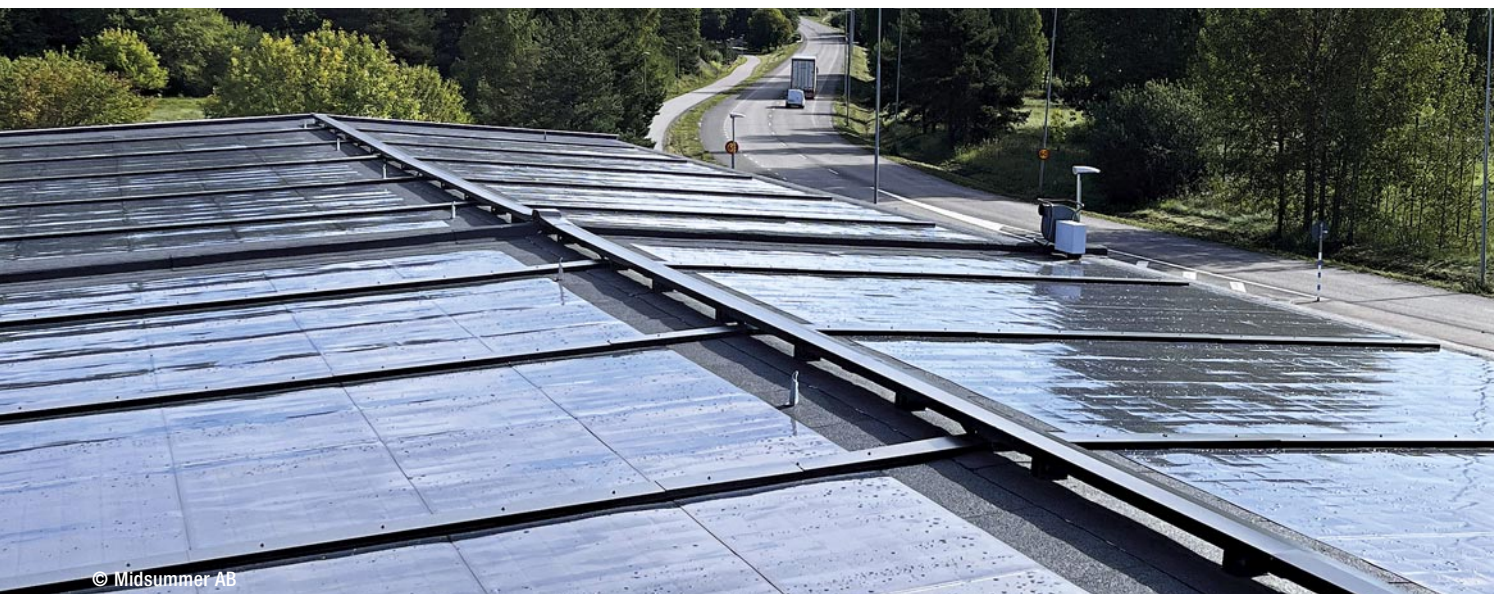
许多屋顶无法承受硅电池板的重量或形状，而轻质CIGS电池板可轻松安装，也适用于既有建筑
