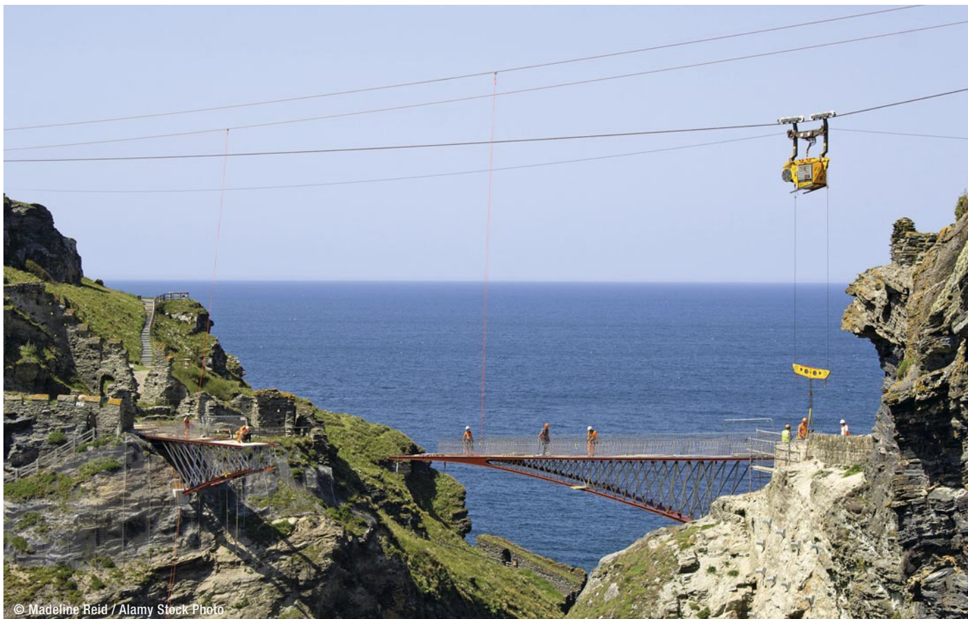
➤ 施工人员利用缆索起重机，从海角吊起钢构件，在横跨峡谷的悬臂梁上进行空中组装
