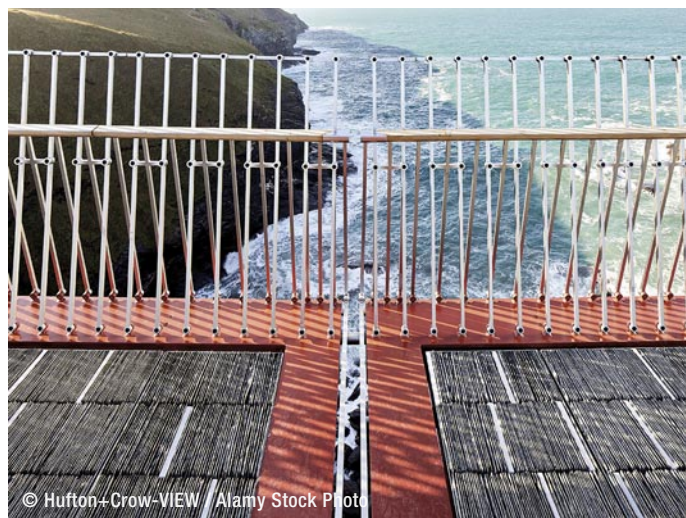
➤ 两道悬臂梁之间的中心间隙约为 40 毫米
