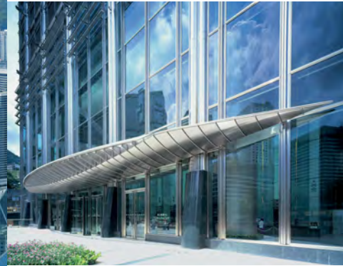
Figuras A y B El Centro Cheung Kong es la construcción más alta en el primer plano de la Figura A. La entrada y otros detalles son visibles en la Figura B. El acero inoxidable tipo 316 con acabado terso de la superficie fue una excelente selección debido a su exposición a la contaminación y a la sal de la costa. Los mecanismos de limpieza para las ventanas fueron construidos dentro del edificio para la fácil limpieza. Como se muestra en la Figura A, éste se encuentra en una cercana proximidad al puerto. (Fotografías Cortesía de Outokumpu)
